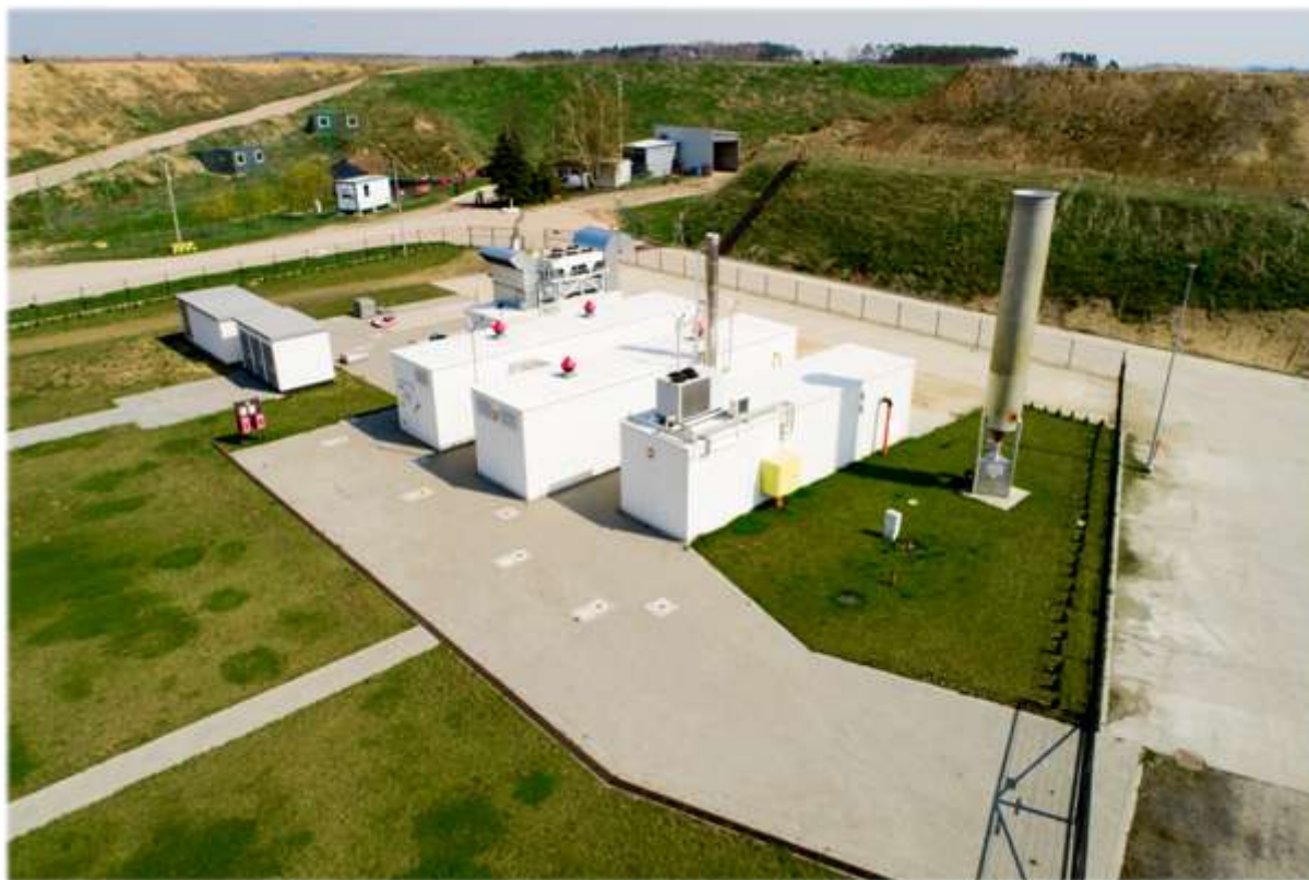
Ryc. 8 Teren systemu energetycznego zlokalizowanego w bezpośrednim sąsiedztwie instalacji OBB.
